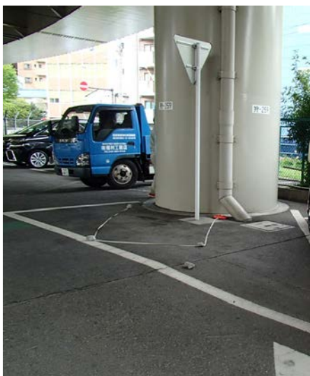
阪東橋自動車駐車場 実施前
